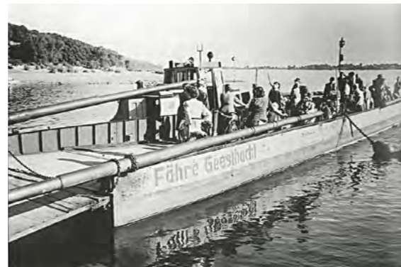
Bis zur Einweihung der Elbbrücke 1966 verkehrt eine Fähre zwischen Geesthacht und Marschacht in Niedersachsen. Aufnahme aus dem Jahr 1954
