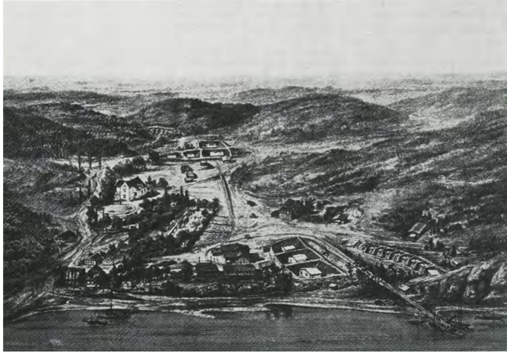
Die Dynamitfabrik Krümmel wird bereits 1865 von Alfred Nobel gegründet. Die Elbe ermöglicht den Transport des Nitroglycerins, der Geesthang und hohe Dünen stellten einen natürlichen Schutzwall bei Explosionen dar.
