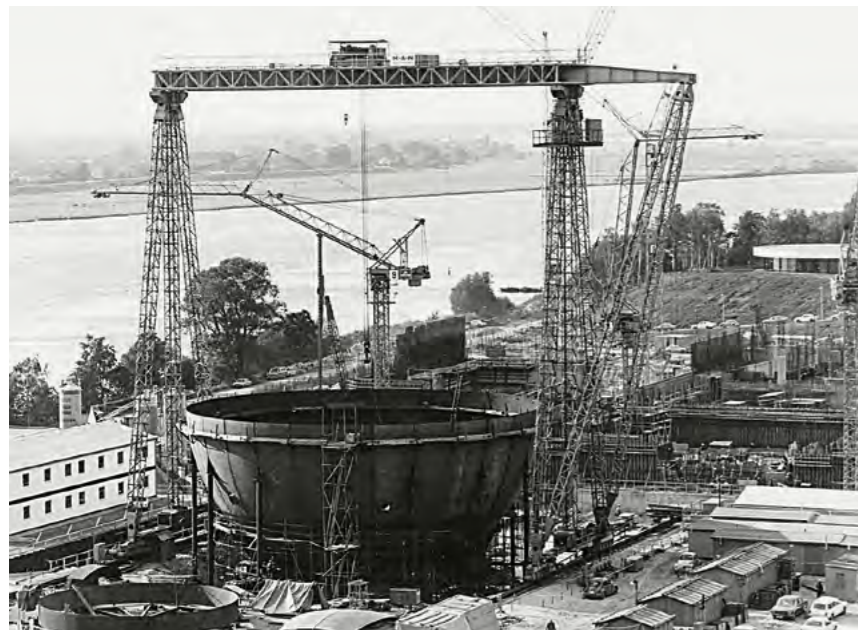
Baubeginn des Atomkraftwerks Krümmel im Jahre 1974, hier mit dem Einbau des Sicherheitsbehälters. Das Kernkraftwerk ist seit 2009 im Stillstand, und auch im Jahr 2020 laufen noch die Planungen zum Rückbau.
